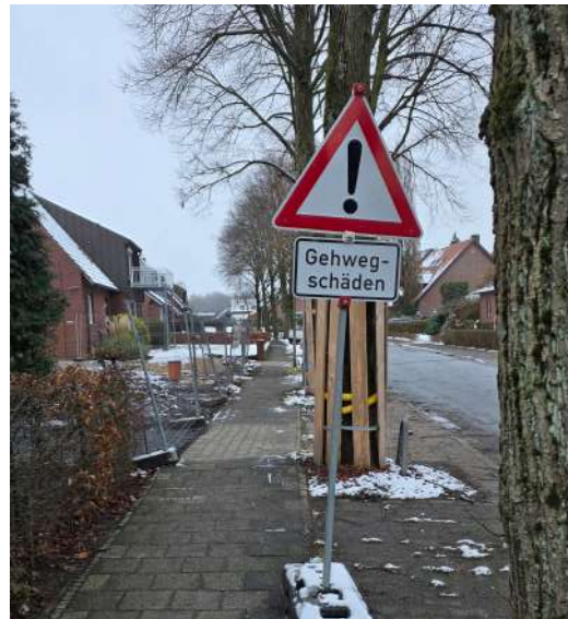
Aus Richtung „Kurneystraße“
